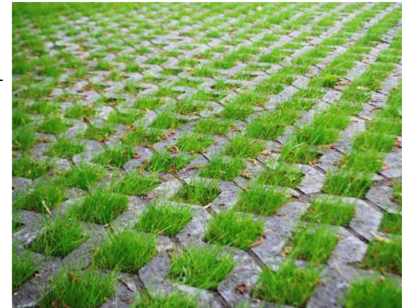
Toegangspad op grasbetonstenen of halfverharding
