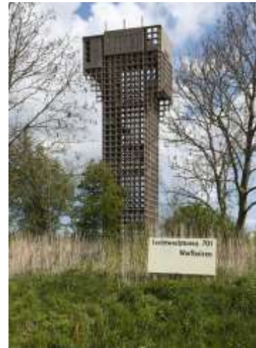
Figuur 43: Luchtwachtoren in Warfhuizen
