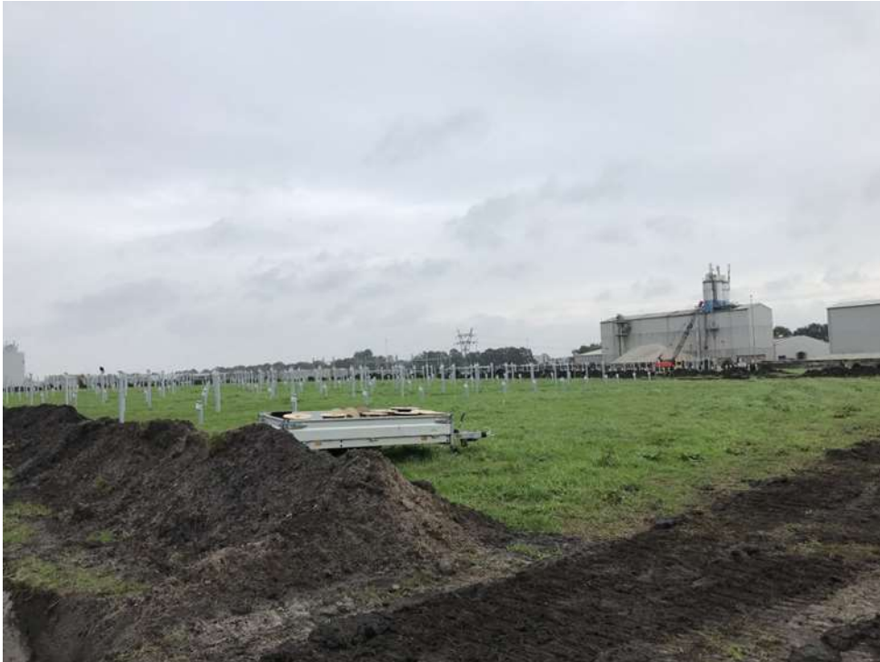
Figuur 44: Palen worden geramd en kabels worden ingegraven
