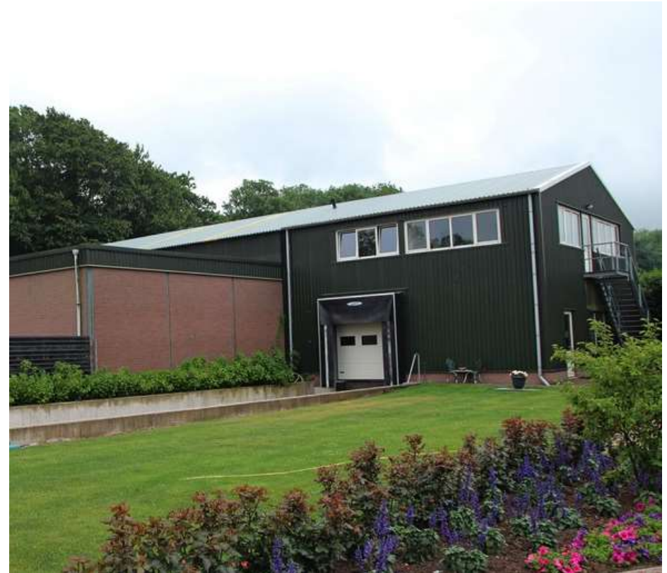
Fruitopslag en koeling aan de Wickenburgseweg, nog zonder panelen
