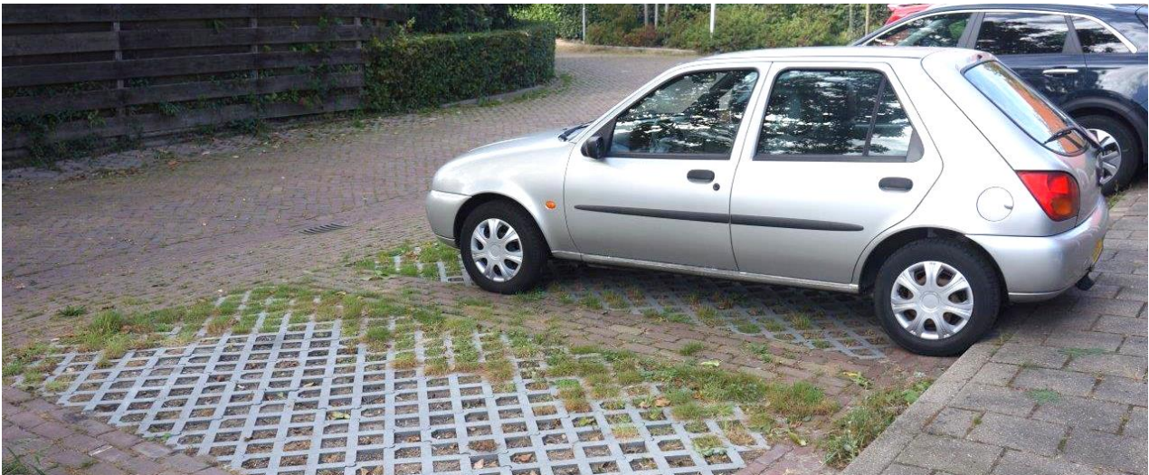
Waterdoorlatende verharding op een parkeerplaats op de Kosterstang ter bevordering van infiltratie
