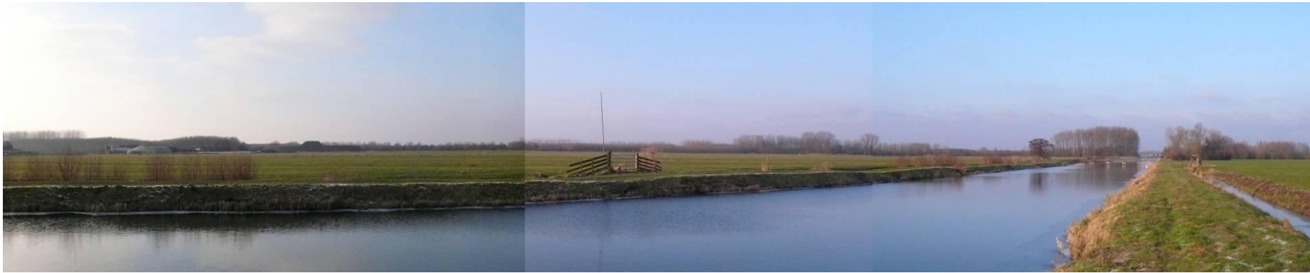
Het open schootsveld rond het Werk aan de Waalse wetering met op de voorgrond het inundatiekanaal. Beide onderdeel van het Nieuwe Hollandse Waterlinie
