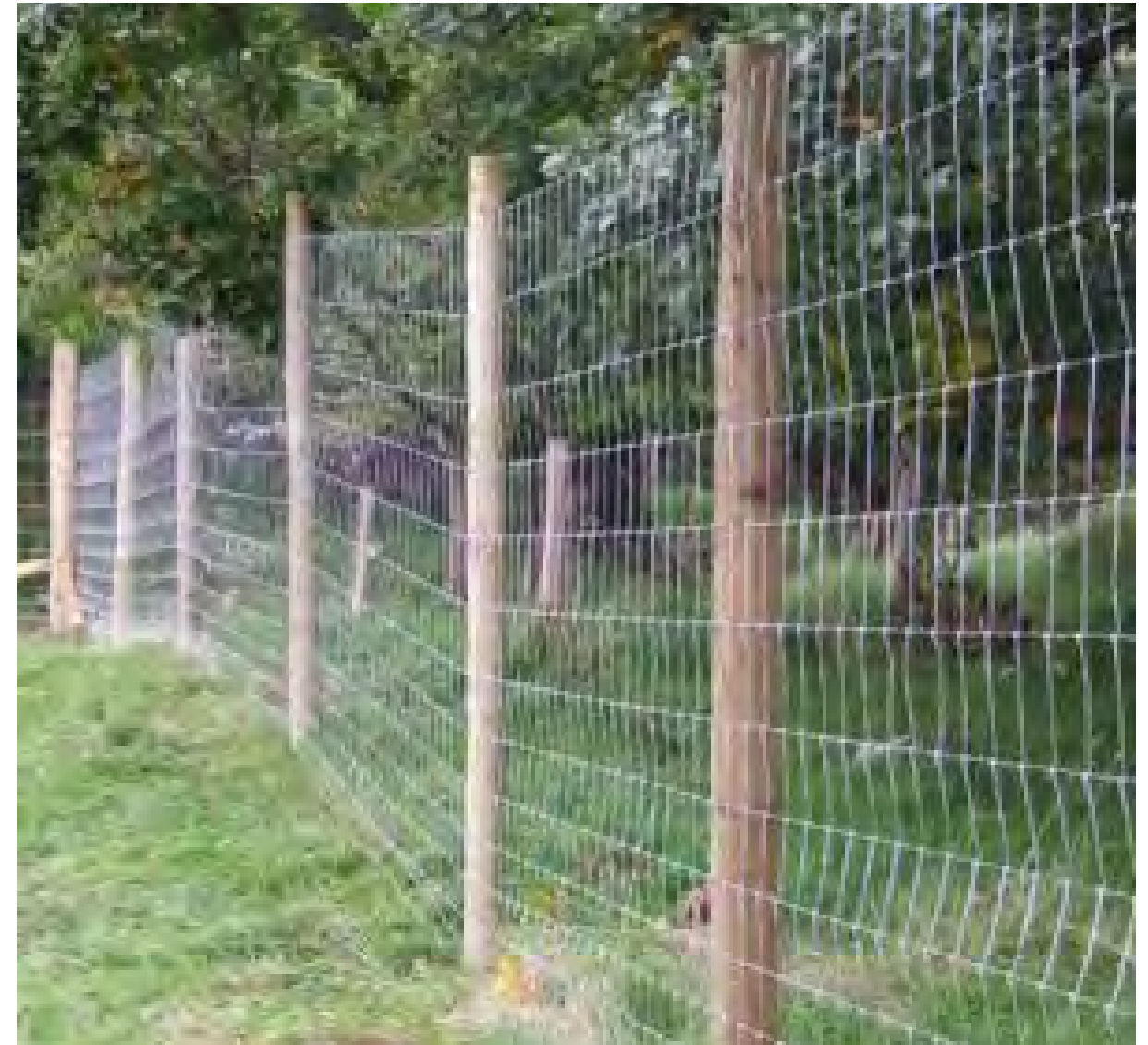
Afbeelding 38. Landschappelijk hekwerk met houten palen, schapengaas, ruimte aan onderzijde (na aanleg).
