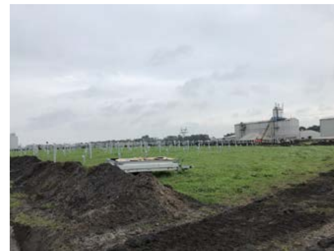
Afbeelding 6.1: palen worden geramd en kabels worden ingegraven.
