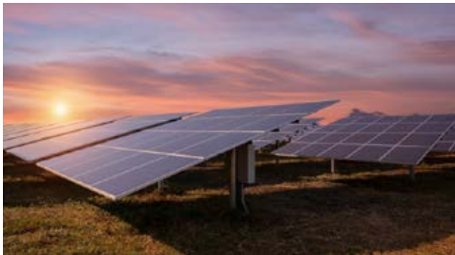
Afbeelding 8.3: voorbeeld van zonnepalen op tafels met daaronder een omvormer.
