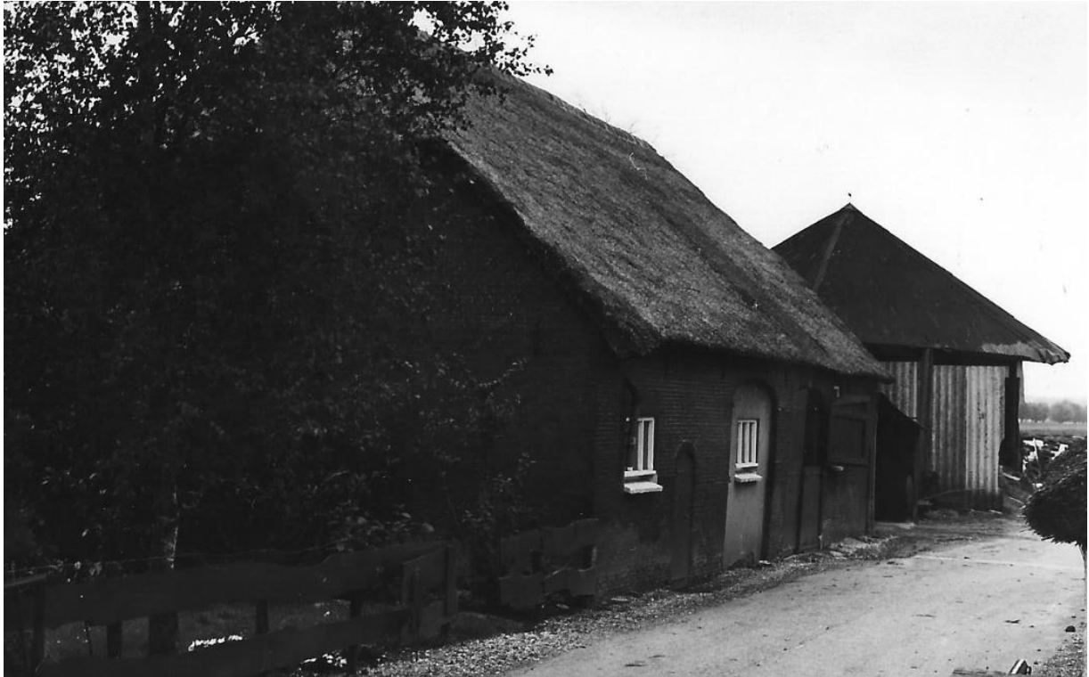
Figuur 4: Opname van de schuur. Duidelijk zichtbaar is de dichtgemetselde, brede doorgang. (PA)
