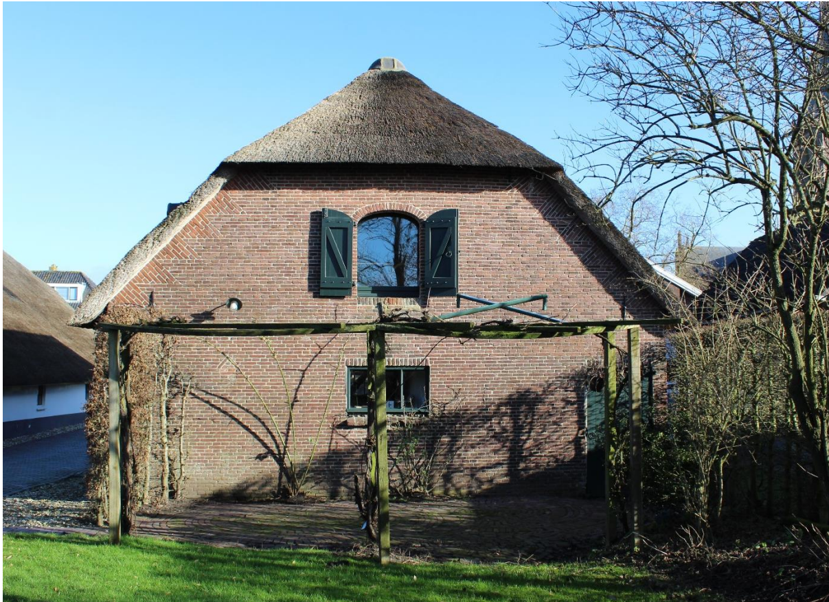
Figuur 12: De zuidgevel.
