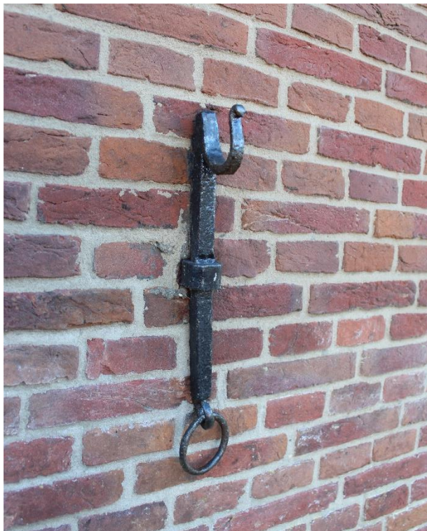
Figuur 11: Het muuranker met ring.
