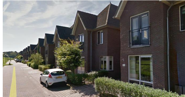
uniformiteit: Slotmuur (bron: Google Earth)
