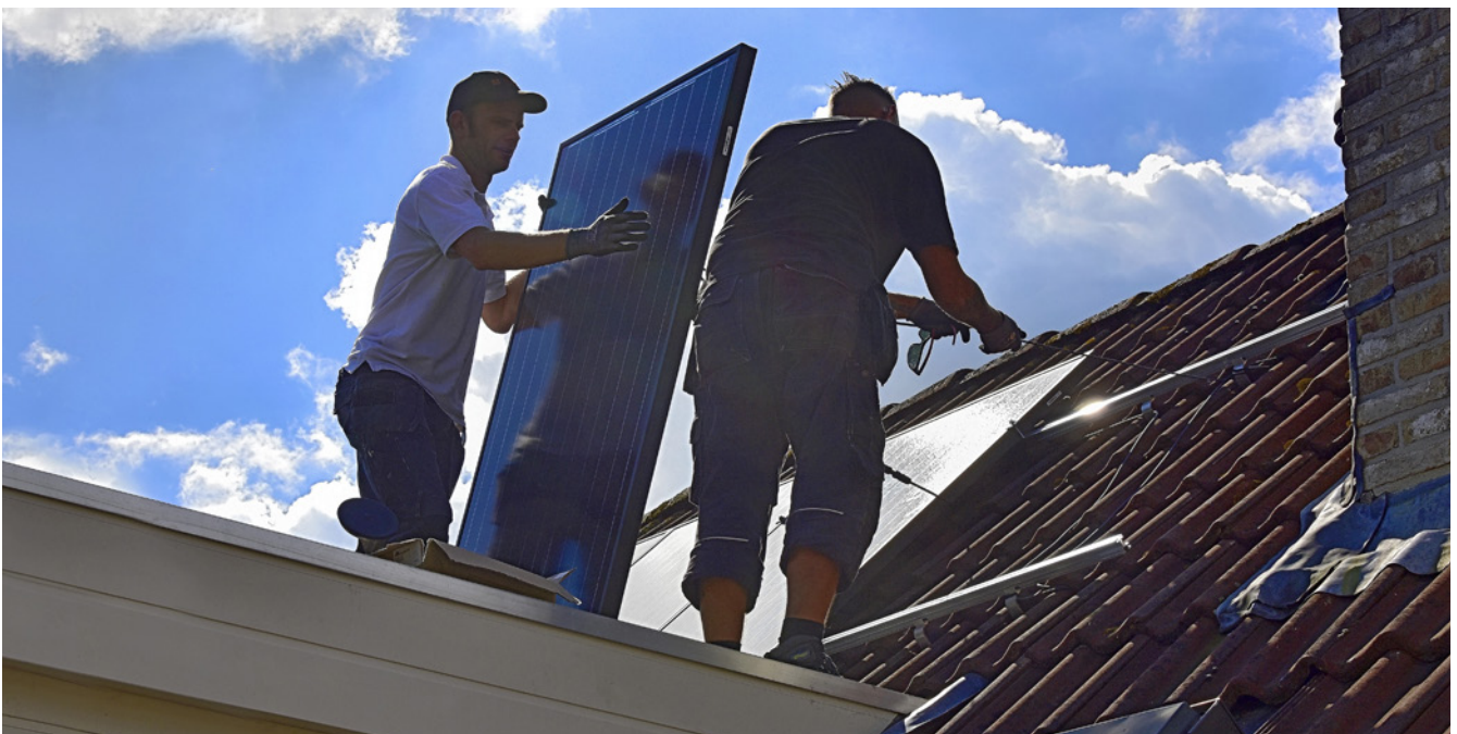
Plaatsen van egaal zwarte zonnepanelen op het achterdakvlak van een woonhuis
