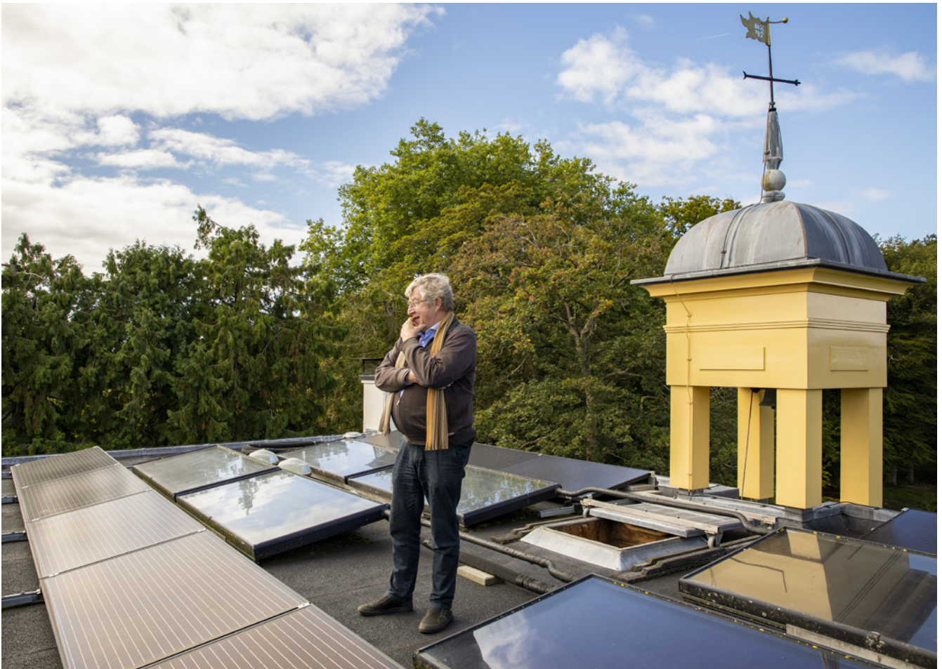
Eigenaar tussen zonnepanelen – herkenbaar aan de zilveren strepen – en zonnecollectoren – zonder strepen
