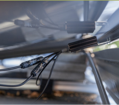
Power optimizer onder zonnepaneel als oplossing bij schaduwval, zonder panelen te verplaatsen naar schaduwvrije plekken die zichtbaarder zijn
