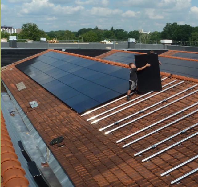
Montage van panelen boven het dak om de pannen te sparen
