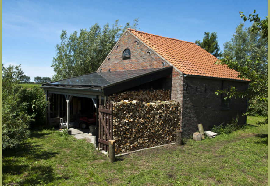
Minder belangrijk bijgebouw als alternatieve locatie voor zonnepanelen
