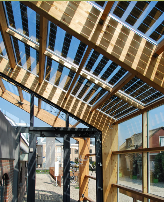
Pv-glas voor stroomopwekking met zichtbare zonnecellen, geplaatst in een moderne aanbouw
