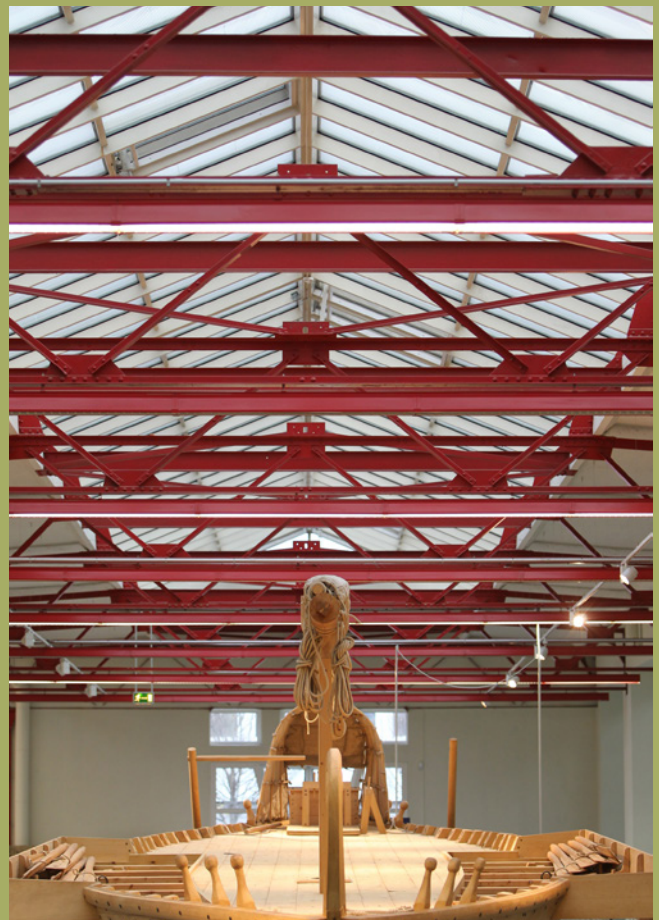
Pv-glas voor stroomopwekking met onzichtbare (amorfe) zonnecellen, geplaatst in een lichtstraat
