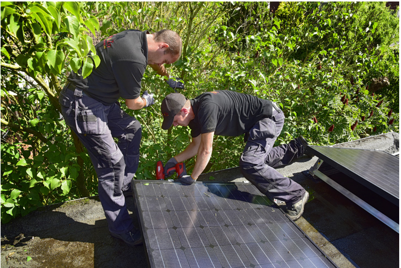
Installateurs aan het werk
