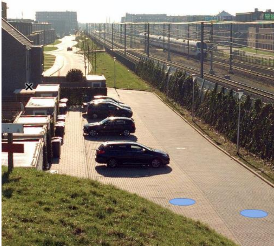
Figuur 1 Geluidsscherm langs de spoorlijn ter hoogte van het Grensspoor
